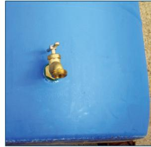
Figura 17. Grifo de manguera hacia abajo.
