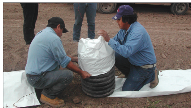
Figura 5a. Conectando dos rollos de politubo.
