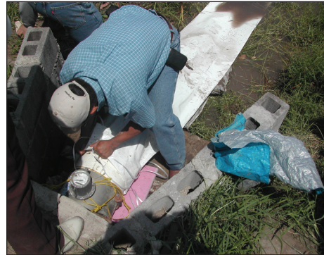
Figura 4a. Apretando el politubo al tubo de descarga para evitar fugas de agua.
