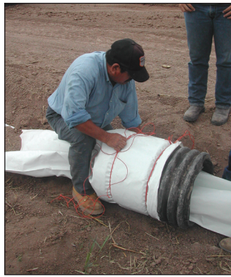
Figura 5c. Asegúrese de hacer un buen amarre para evitar fugas
